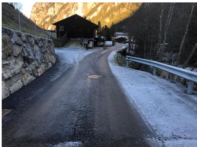
Die Bergmauern sind fertiggestellt und die Leitschienen montiert. Ein Teil der Asphaltierungsarbeiten wurde durchgeführt, der Rest der Asphaltierung wird aus Kostengründen auf 2021 verschoben.
